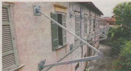
LAVORI IN VIA UMBERTO I
